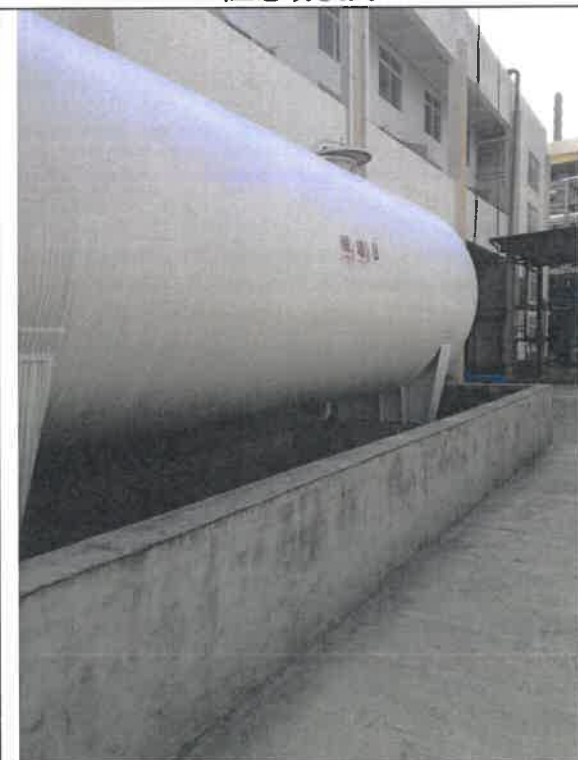
储罐区围堰
